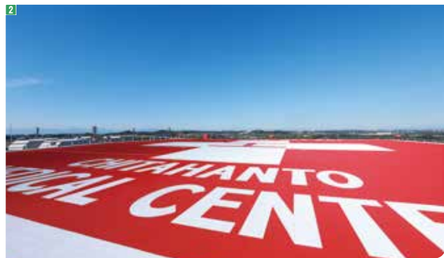
1救命救急センターでは、搬送受け入れ後、迅速な対応ができるよう設備を増強しました 2屋上には大型ヘリポートを設置し、ドクターヘリによる緊急搬送体制も充実しました
